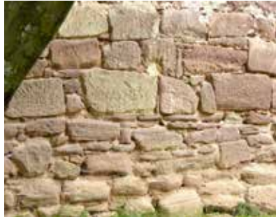
Typisches Mauerwerk aus Sandstein
