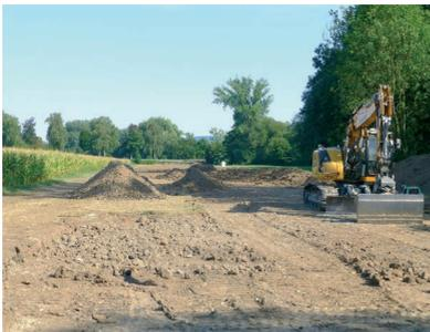
*Bei der Verlegung der Abwasserleitung im sehr trockenen Sommer 2018 waren keine aufwändigen Stabilisierungsmaßnahmen des Bodens erforderlich.*
