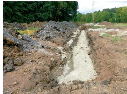
*Die Abwasserleitung wurde in Kies und Sand eingebettet und mitten durch das Feuchtgebiet verlegt.*
